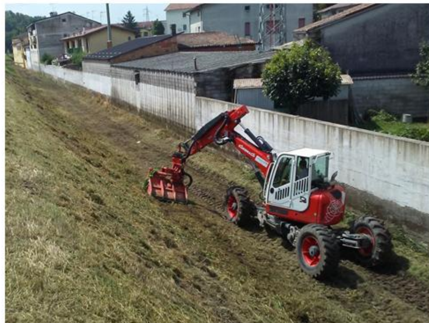
Sfalcio delle sponde del Vaso Cacciabella con escavatore tipo ragno in Comune di Asola
