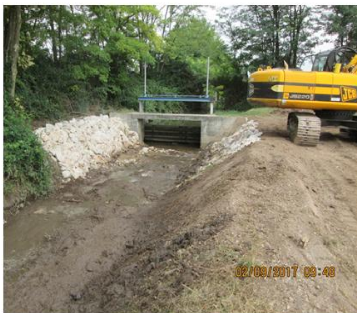
Consolidamento spondale a valle del manufatto di sostegno sul Branchellino in Comune di Asola
