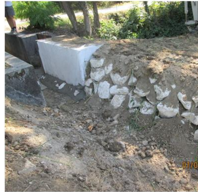
Sistemazione sostegno sul dugale Ravana di Sotto in Comune di Asola
