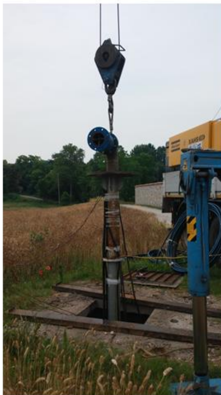
Spurgo d'urgenza del pozzo Barche in Comune di Solferino nel mese di giugno
