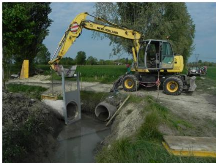
Rifacimento sostegno irriguo Colombaretta in Comune di Castel Goffredo
