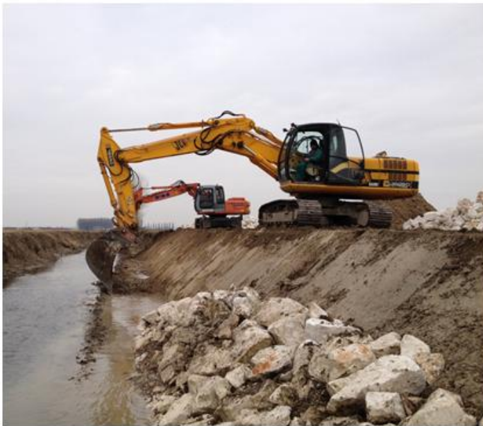
Consolidamento spondale Seriola Piubega in Comune di Piubega, con il contributo del privato
