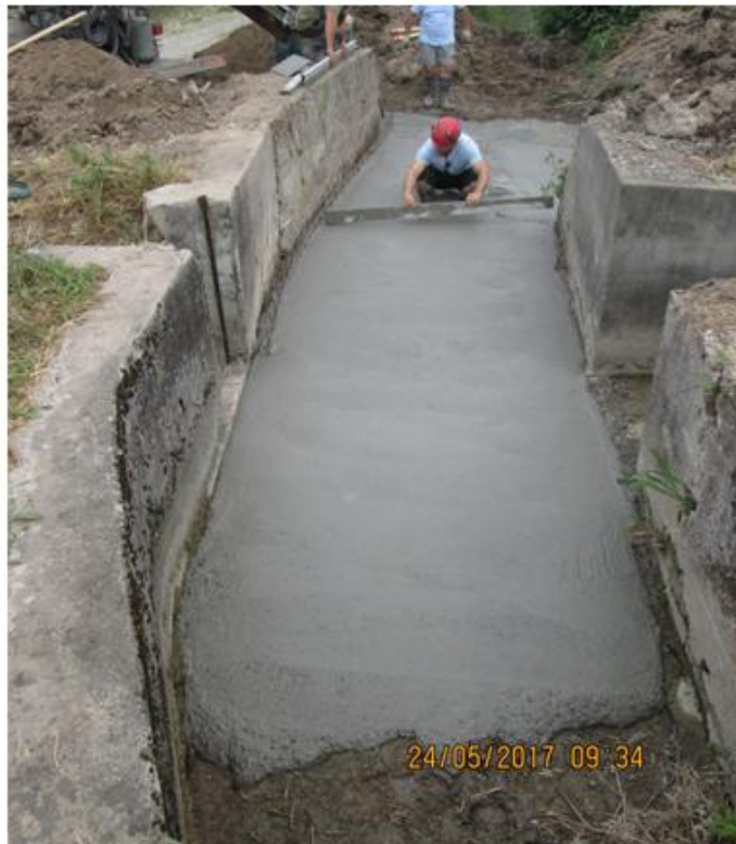
Sistemazione manufatto di scarico sul Vaso Conta in Comune di Casalromano
