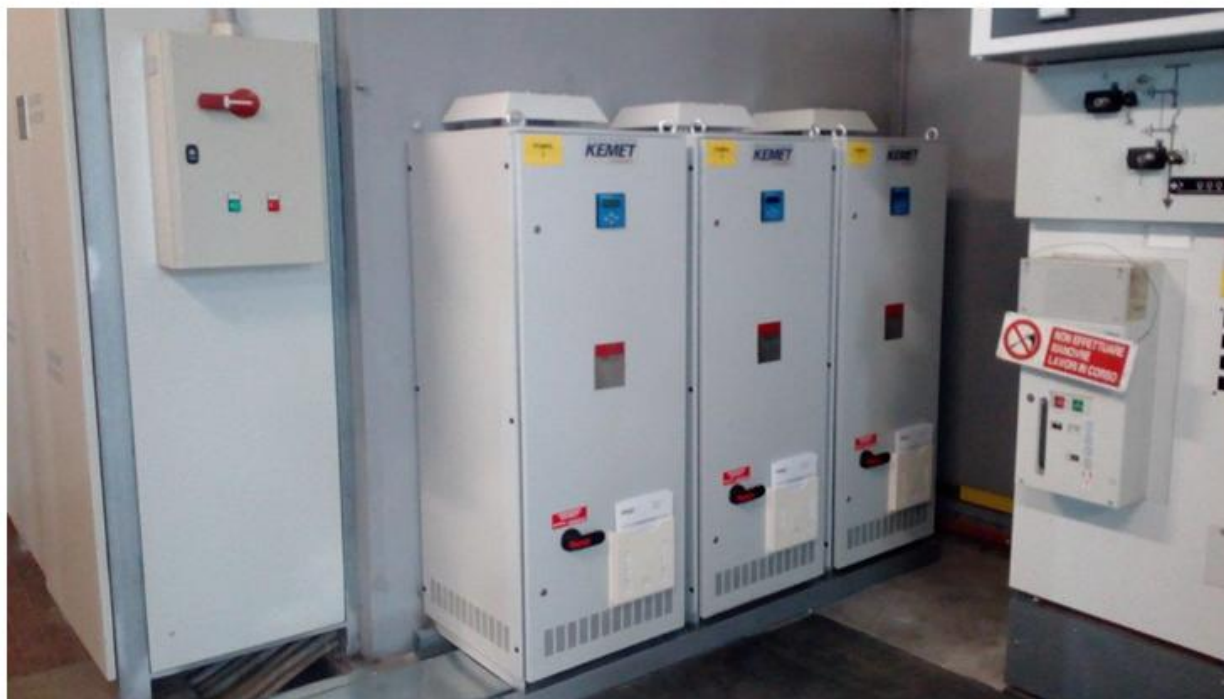
Impianto Colombarola, centrale Colombarola: installazione di nuovo sistema di rifasamento industriale automatico
