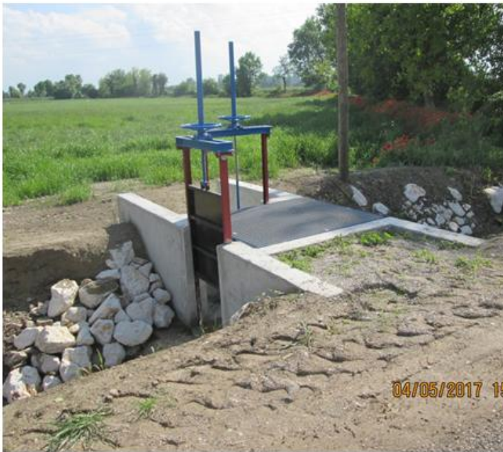
Rifacimento manufatto di sostegno e derivazione sul dugale Testi Mattina in Comune di Asola
