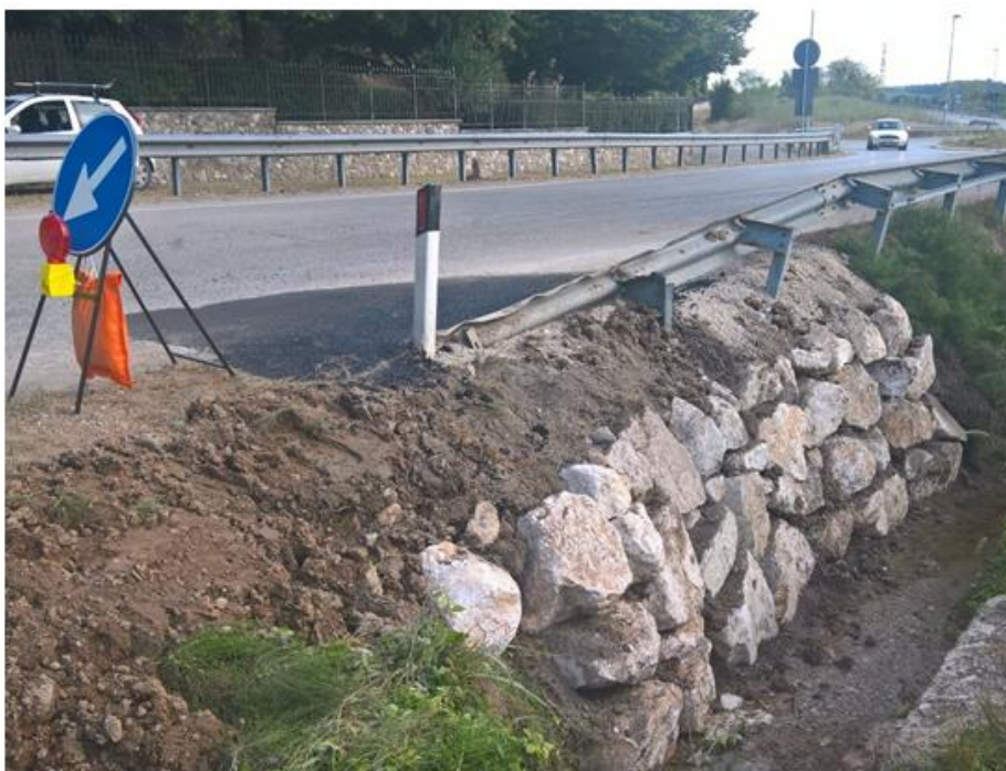
Riparazione condotta irrigua con taglio strada sull'impianto Pozzolengo
