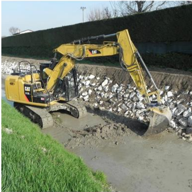
Consolidamento spondale Tartaro Fuga in Comune di Asola con il contributo del privato
