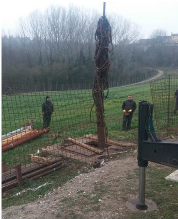
Sostituzione pompa pozzo Barche in Comune di Solferino
