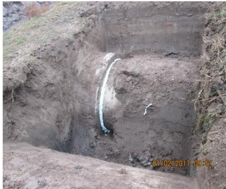
Interventi di riparazione perdite sottopassi del Vaso Turca in Comune di Asola
