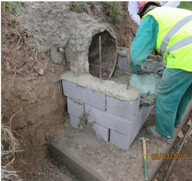
Sistemazione derivazione Vaso Canneta in Comune di Casalromano
