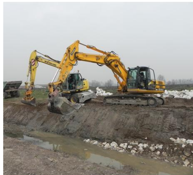
Consolidamento spondale Vaso Gozzolina in Comune di Piubega
