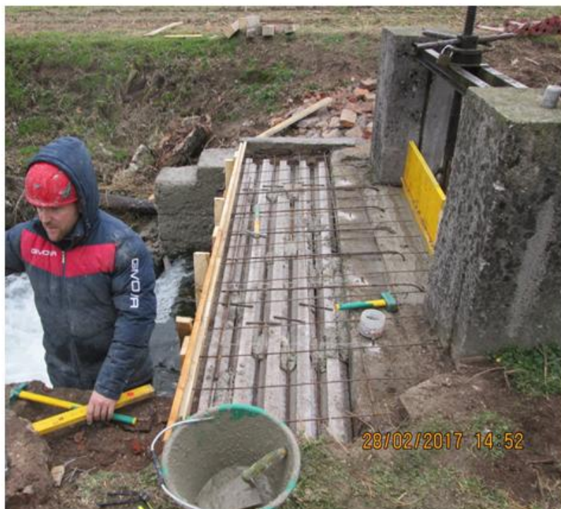
Consolidamento manufatto di derivazione ramo Casalromano sul Vaso Canneta
