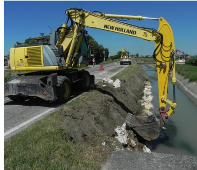
Consolidamento spondale Seriola Piubega sulla SP1 in Comune di Piubega in collaborazione con la Provincia
