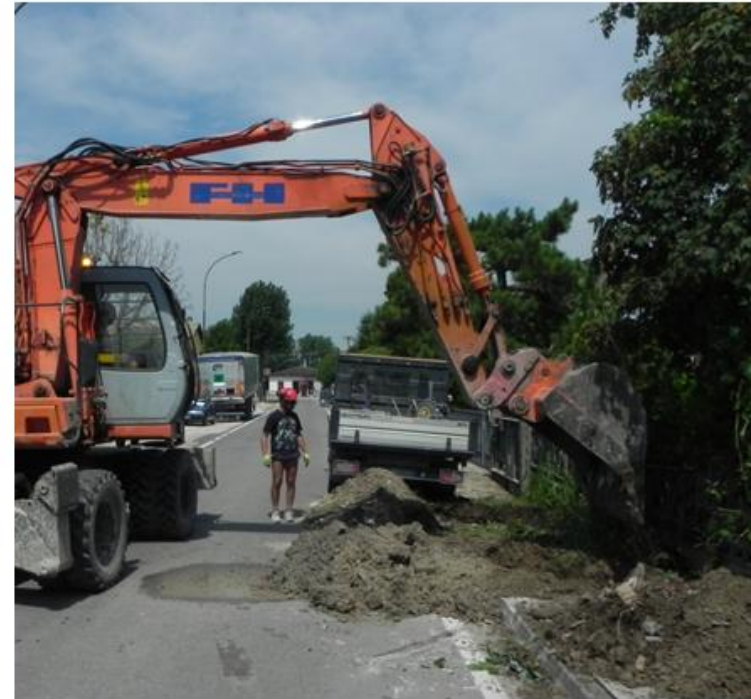
Intervento straordinario per la rimozione di un tratto di tombinatura crollato sul Fosso del Pozzo in Comune di Redonesco
