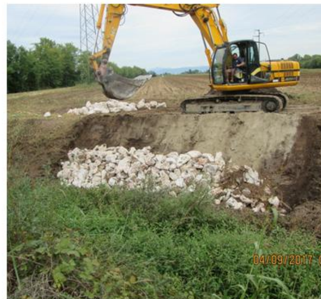
Consolidamento spondale Branchellino in Comune di Asola
