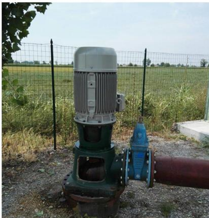
Installazione nuovo motore su pozzo Bussole in Comune di Asola
