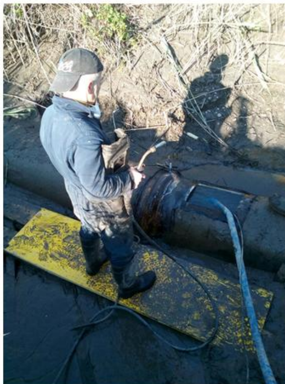
Riparazione straordinaria condotta principale DN 600 impianto Colombarola località Signorelli
