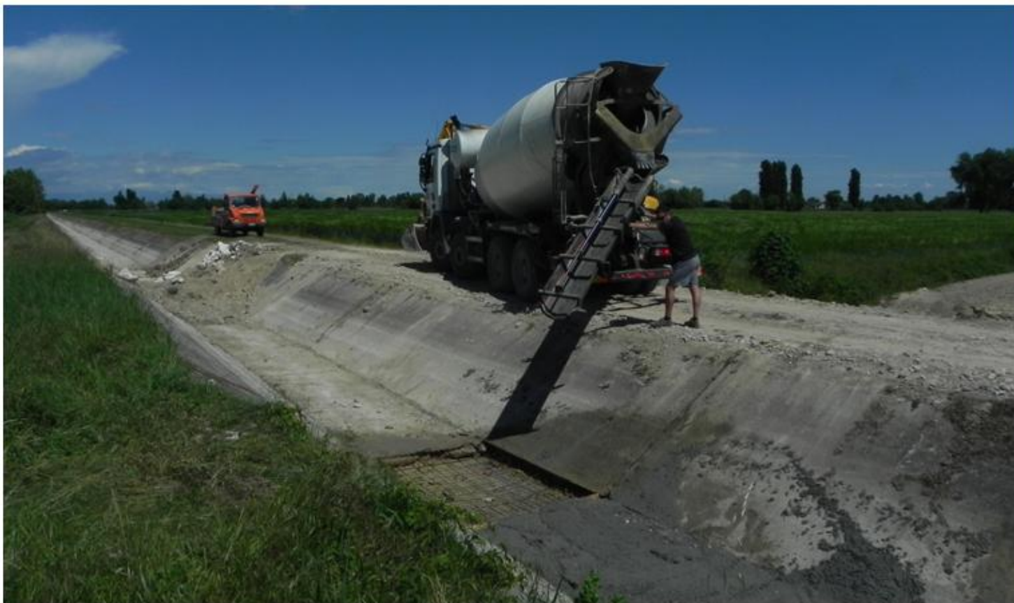
Ripresa piastre del rivestimento sul Canale Primario di Mariana in Comune di Piubega
