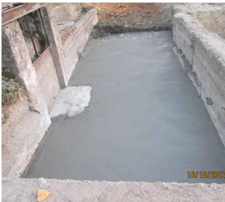
Intervento d'urgenza di riparazione navetta Cacciabella in Comune di Asola
