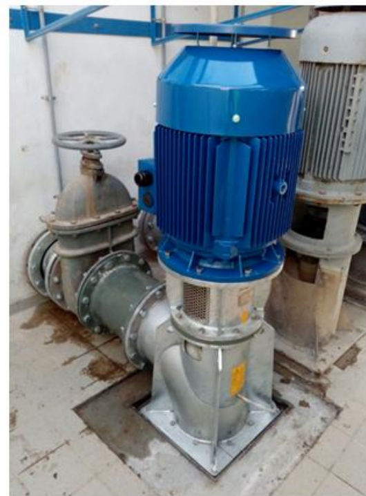
Installazione nuova pompa nell'impianto di sollevamento da fiume Chiese in località Camporegio di Asola
