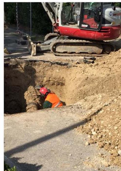
Riparazione condotta irrigua con taglio strada sull'impianto Colombarola
