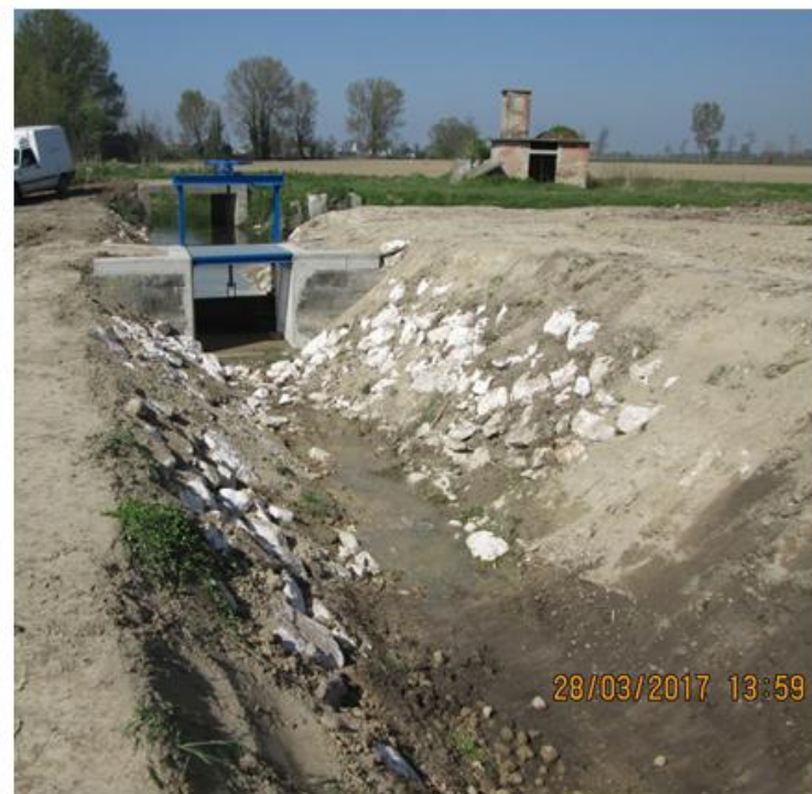
Ristrutturazione manufatto di derivazione ramo Casalromano sul Vaso Canneta
