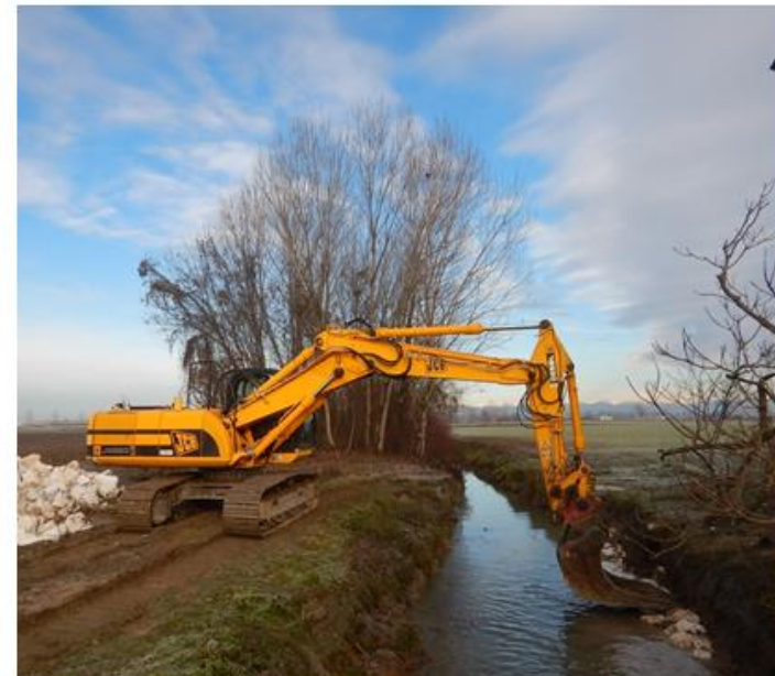
Consolidamento spondale Roggia Isorella in Comune di Asola
