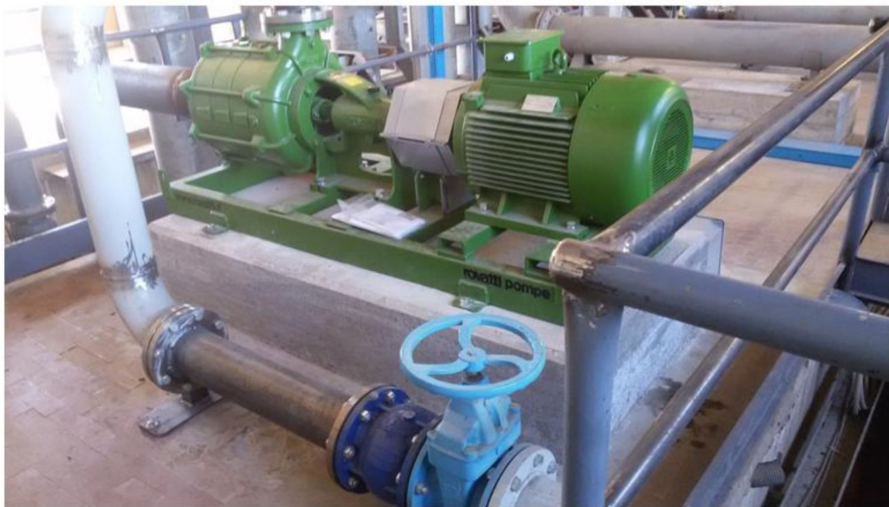
Impianto Colombarola, rilancio Signorelli: sostituzione pompa ad asse orizzontale
