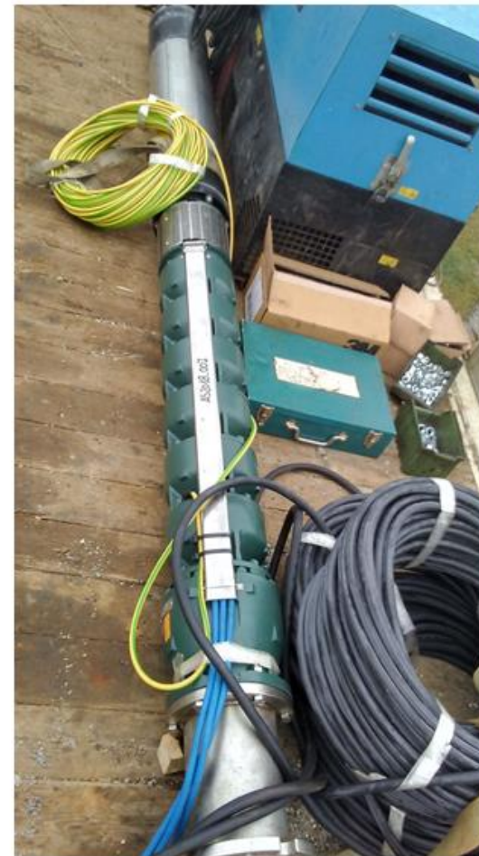
Sostituzione pompa pozzo Barche in Comune di Solferino
