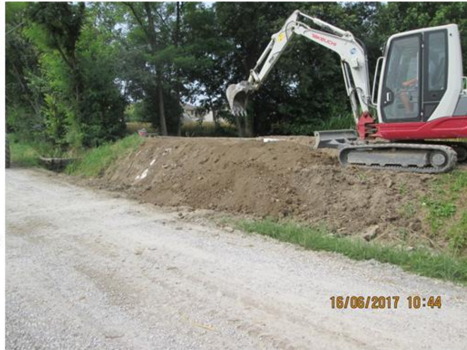
Riparazione navetta del Vaso Conta in Comune di Casalromano
