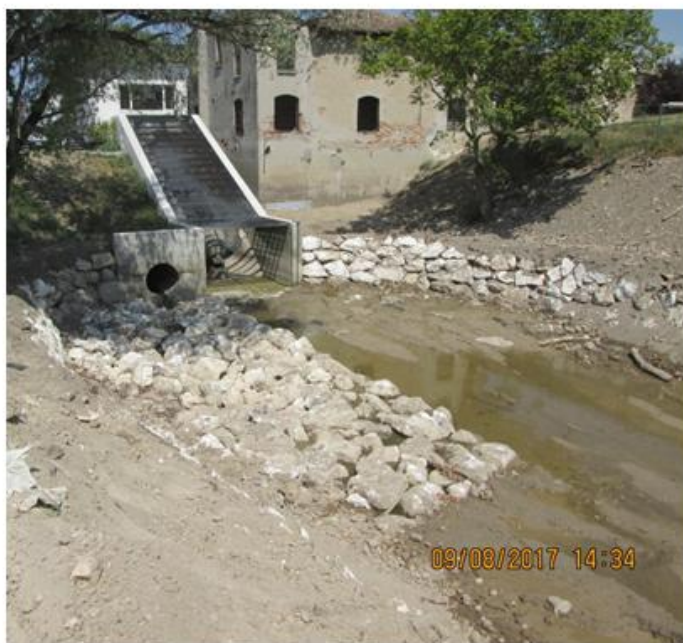
Sistemazione alveo Naviglio di Canneto a valle della centrale idroelettrica Mulino Cartara
