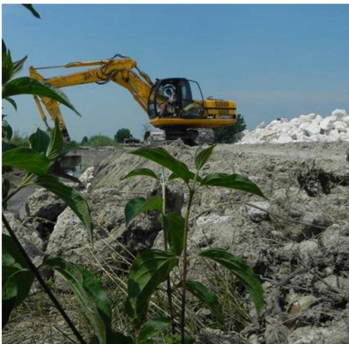
Consolidamento spondale scolo Tornapasso in Comune di Asola
