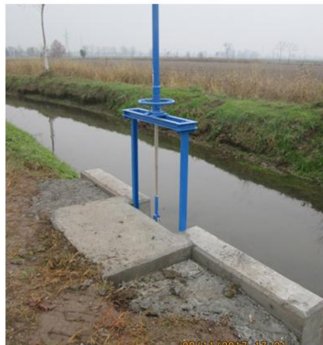
Sistemazione derivazione sul Vaso Cacciabella in Comune di Asola
