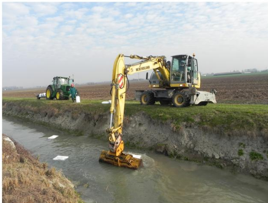
Recupero rifiuti dai canali consortili
