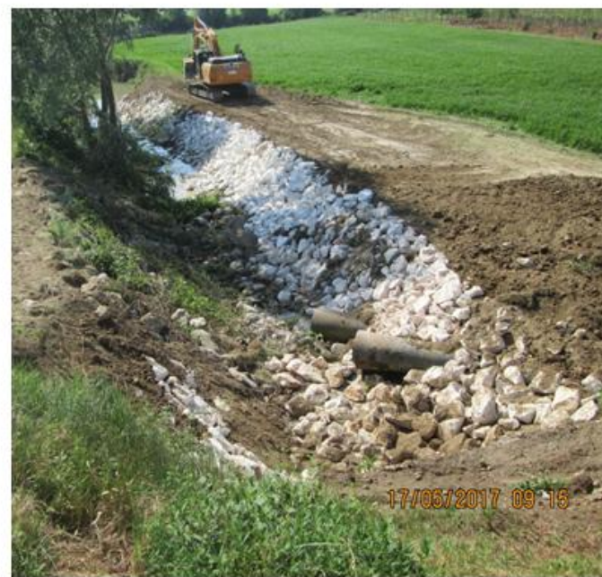
Consolidamento alveo Scolo Regonella a valle dell'impianto idrovoro, in collaborazione con AIPO
