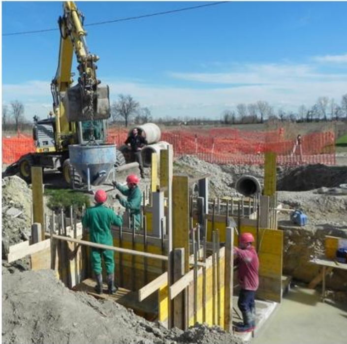
Rifacimento sostegno sul Colatore Tomba in Comune di Piubega
