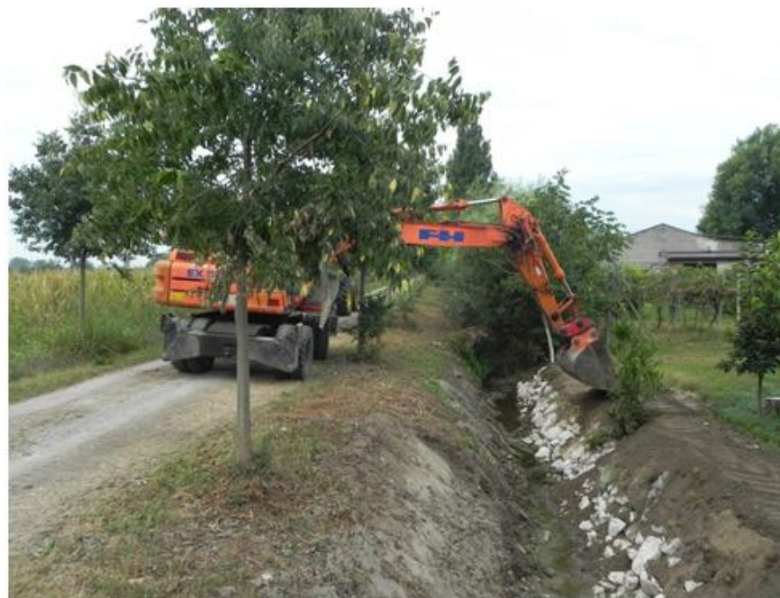
Consolidamento spondale dugale Gazzoldo in Comune di Asola, con il contributo del privato
