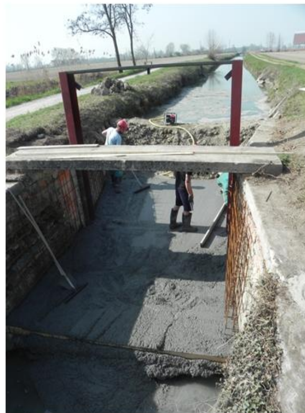
Ristrutturazione sostegno sulla Seriola Piubega in Comune di Piubega
