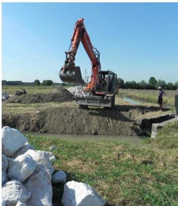
Consolidamento spondale Gambino di Casalpoglio in Comune di Asola con il contributo del privato
