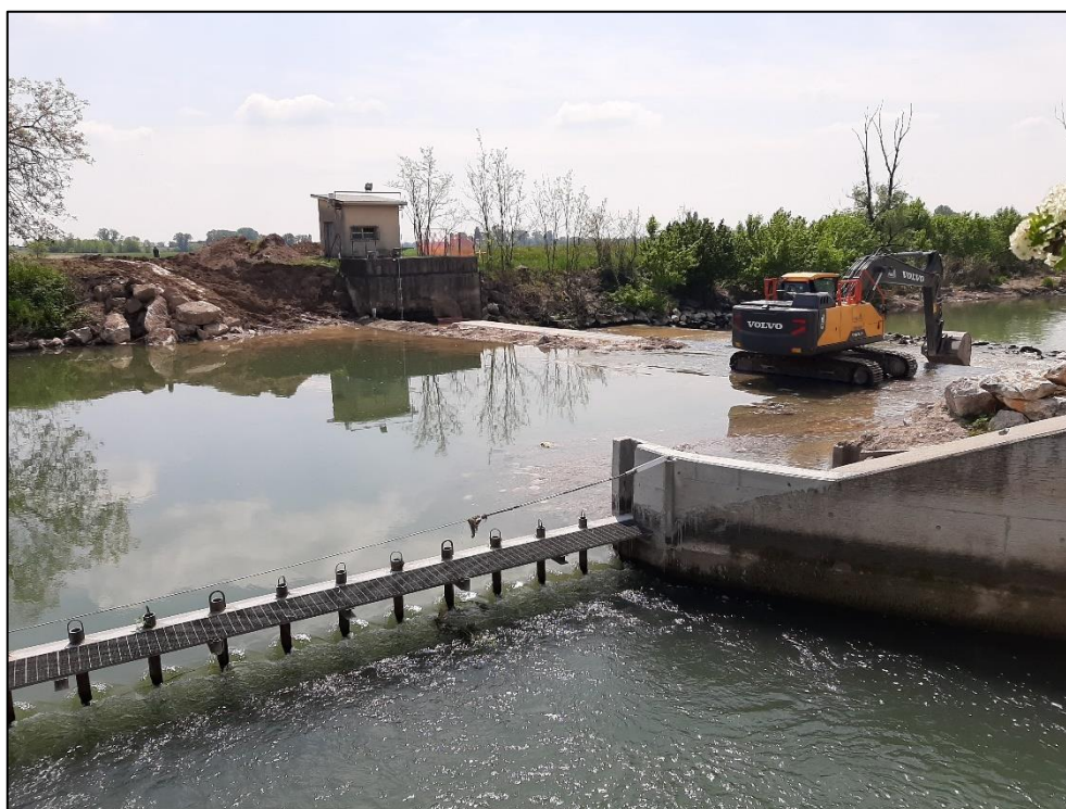
Fig. 2.32 – Ripristino della funzionalità della traversa mobile sul fiume Chiese in comune di Asola
