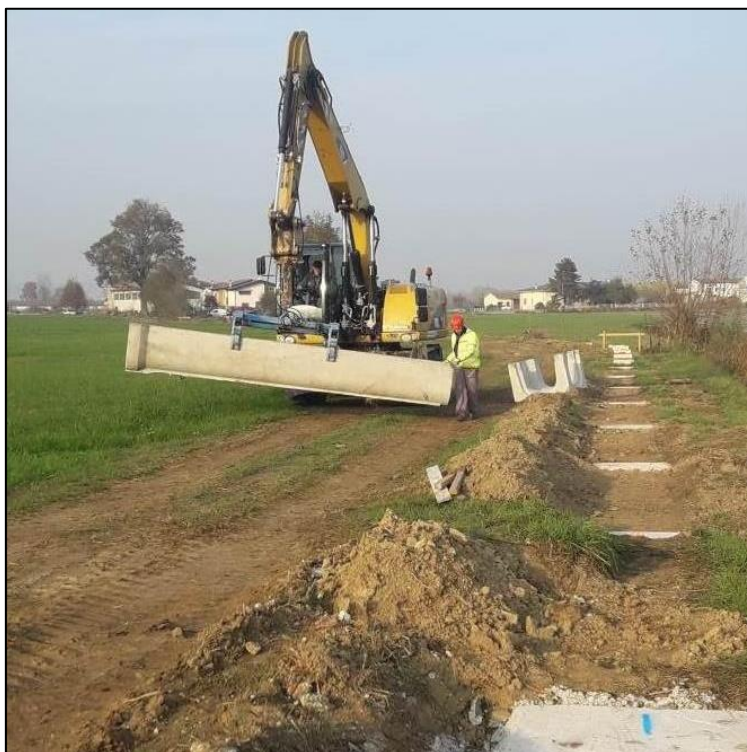
Fig. 2.26 – Sostituzione di tratti di reti irrigue ammalorate
