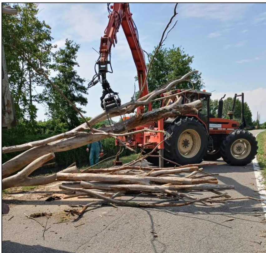
Fig. 2.22 – Rimozione alberature cadute in alveo
