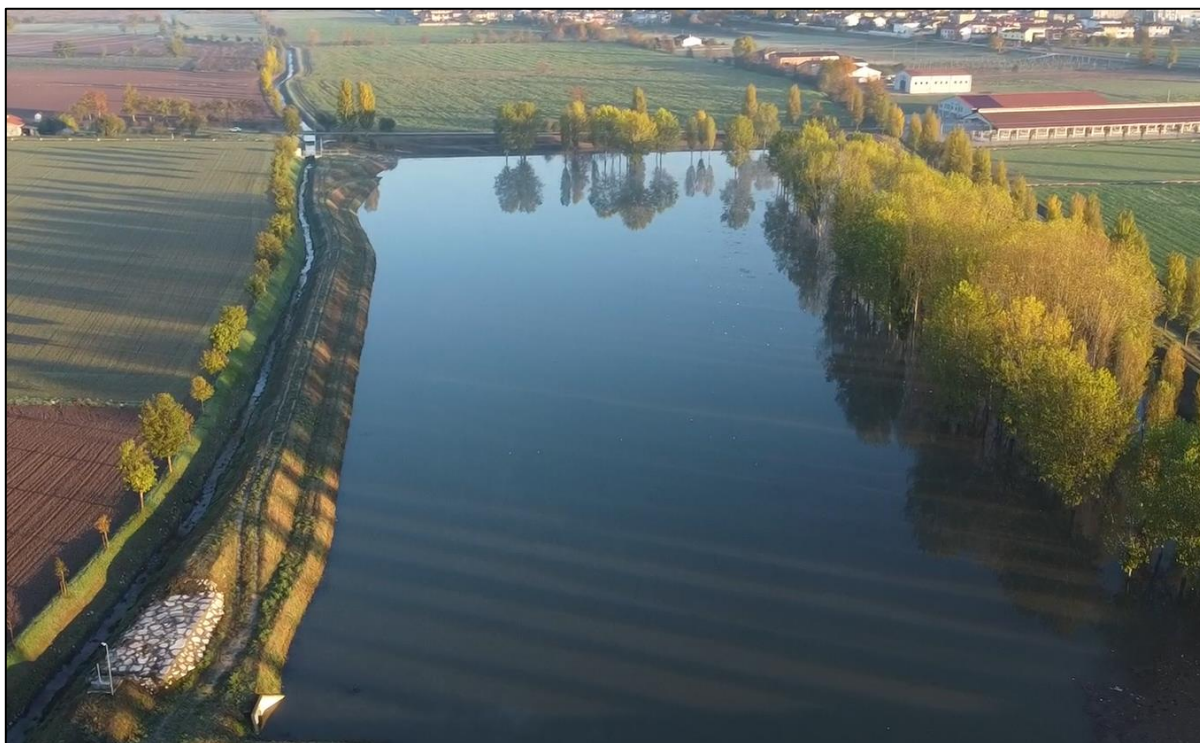
Fig. 2.10 – Vasca di laminazione del Vaso Riale in Comune di Castiglione delle Stiviere
