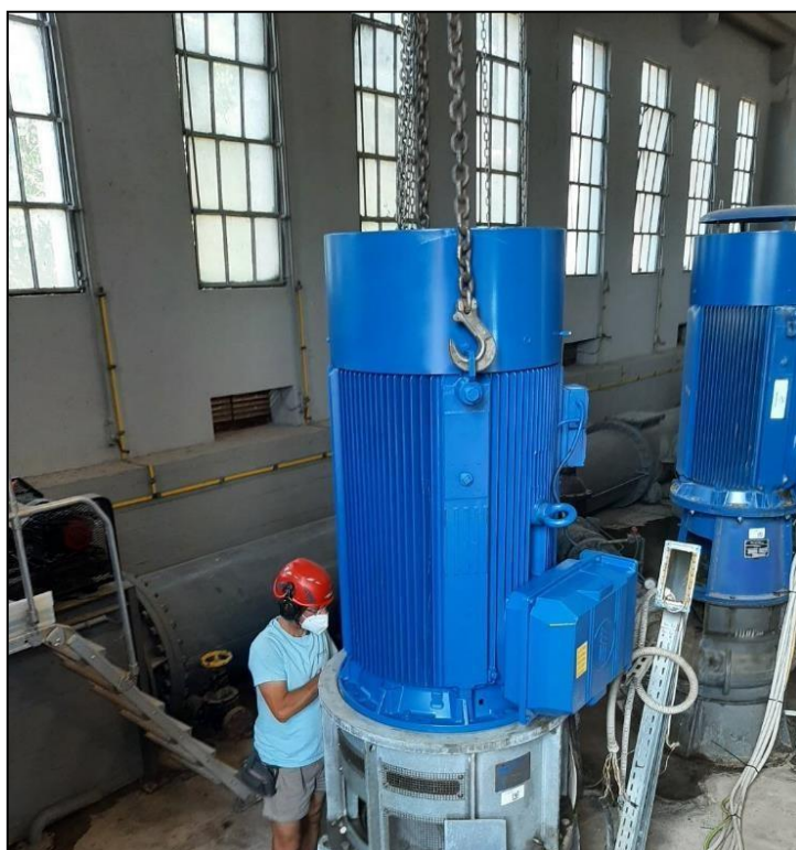
Fig. 2.27 – Riparazione degli impianti elettromeccanici
