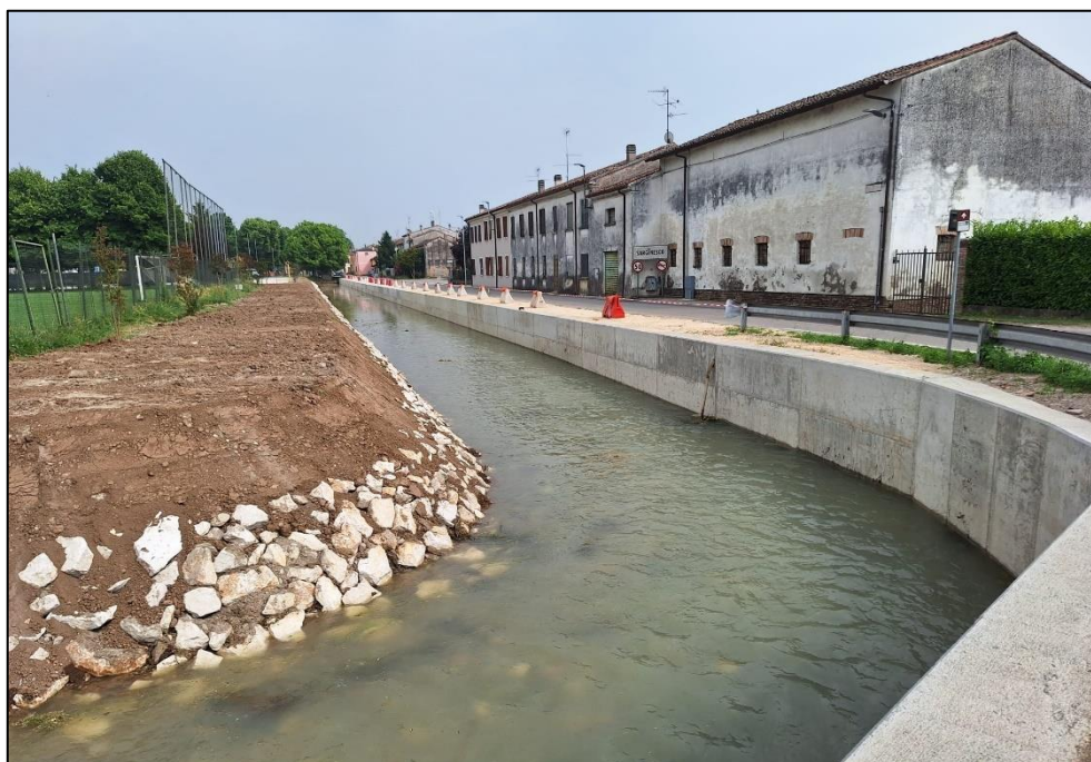
Fig. 2.39 – Pronto intervento per il ripristino del muro di sostegno sulla "Seriola di Castelluccio" in loc. Sarginesco di Castelluccio
