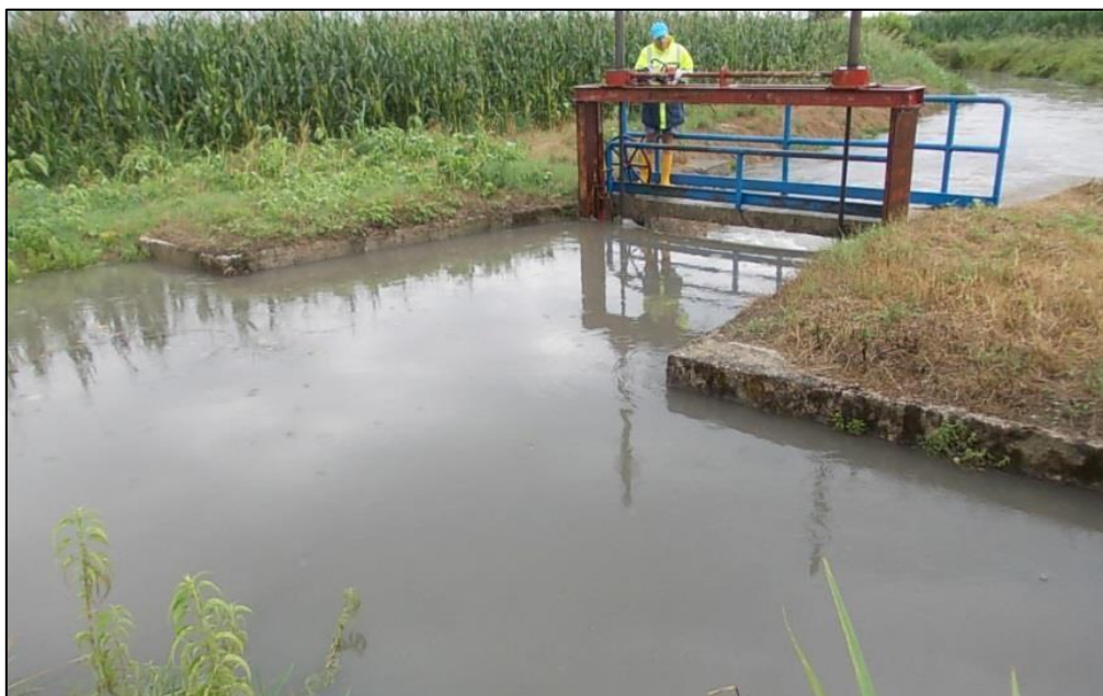
Fig. 2.28 – Manovre di regolazione dei manufatti sui canali
