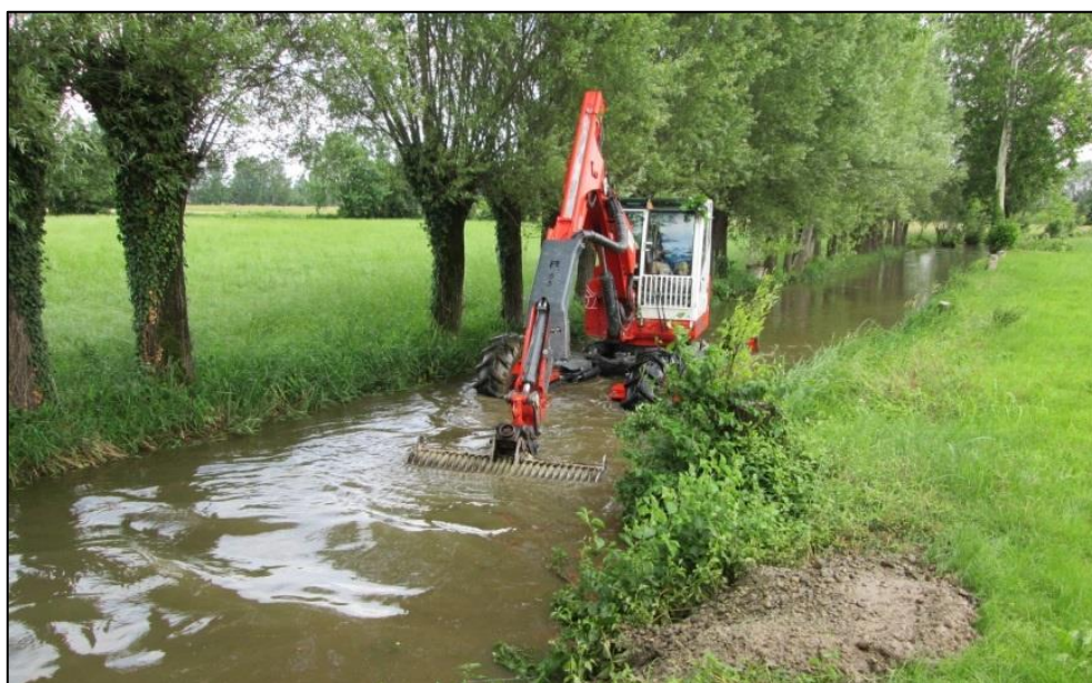
Fig. 2.20 – Espurgo alveo
