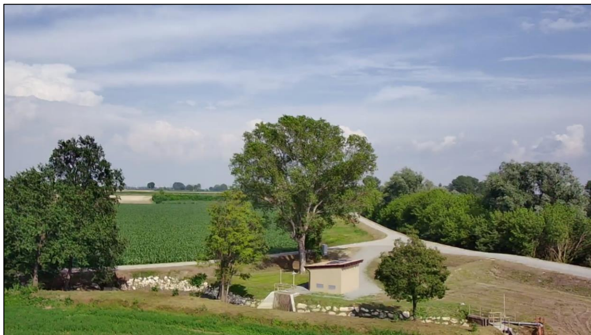
Fig. 2.11 – Impianto idrovaro Gambolo in Comune di Canneto sull'Oglio
