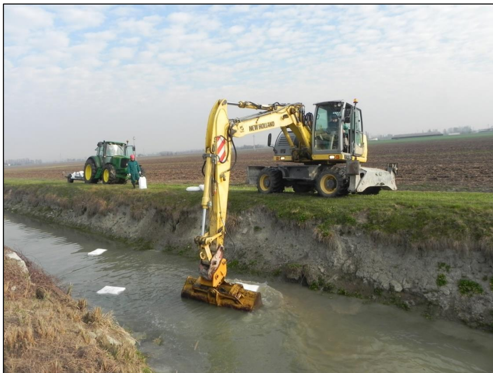
Fig. 2.23 – Rimozione dei rifiuti abbandonati in alveo
