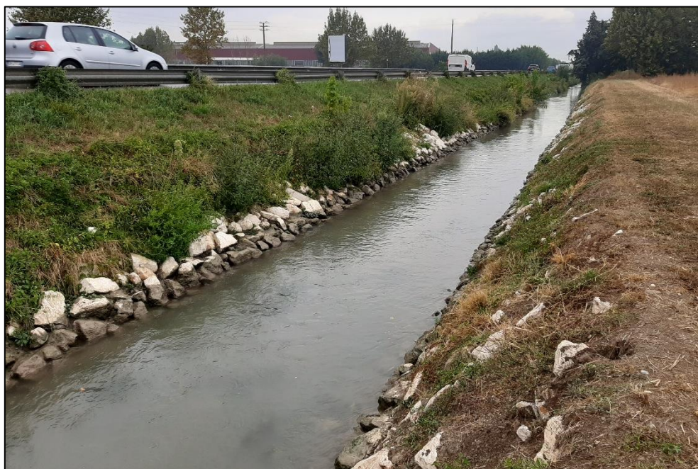
Fig. 2.45 – Lavori di consolidamento argine destro e sinistro Scolo Caldone nel tratto In fregio alla s.p. 236 in comune di Volta Mantovana
