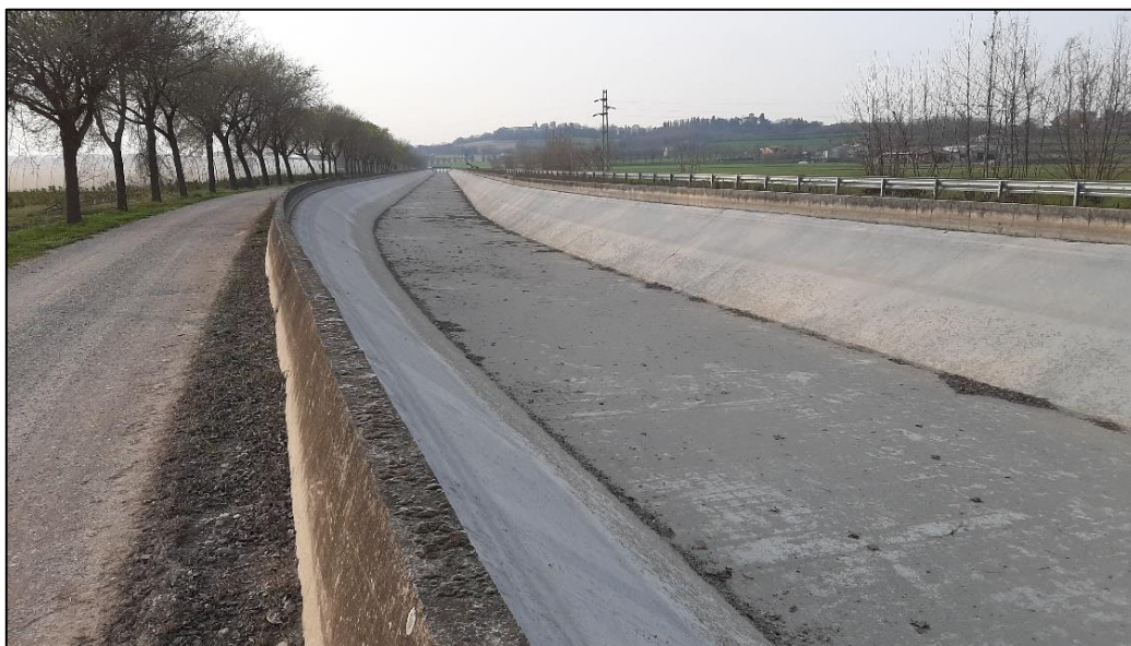
Fig. 2.36 – PSRN Lavori di ristrutturazione del Canale Virgilio da Ponte Trento a Ponte Cereta in Comune di Volta Mantovana
