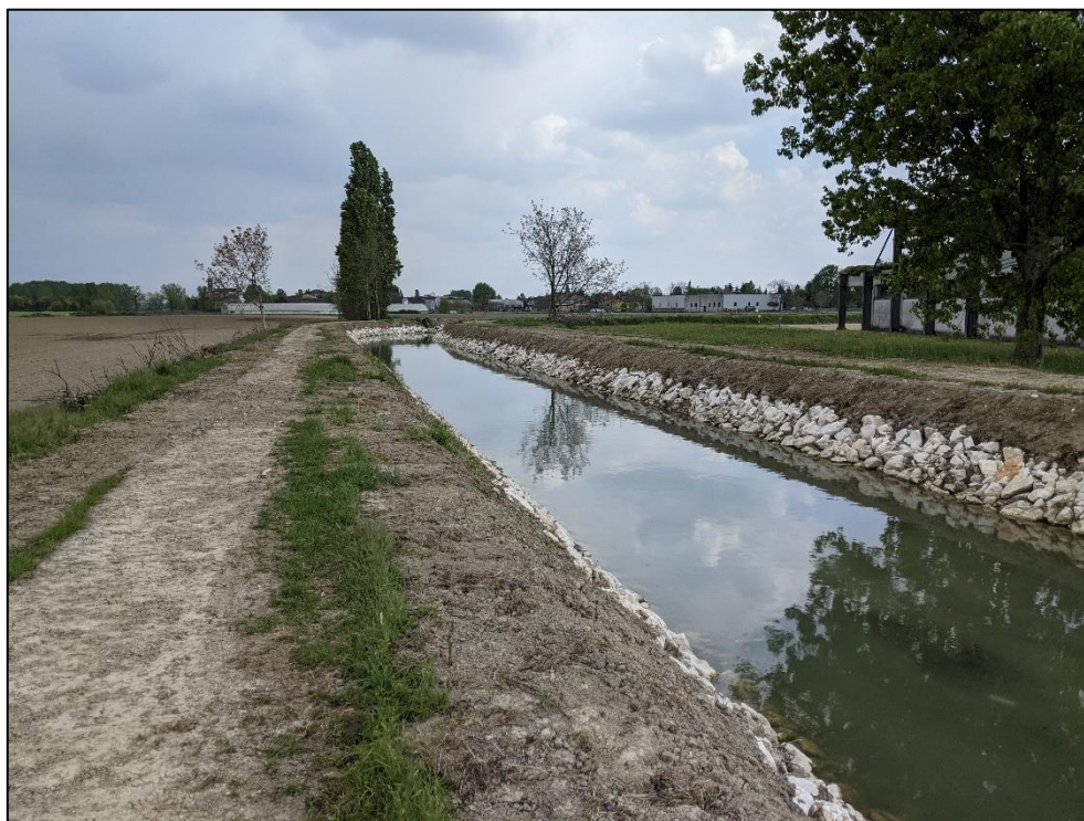
Fig. 2.33 – Ripristino della sicurezza spondale della Seriola Piubega in Comune di Ceresara
