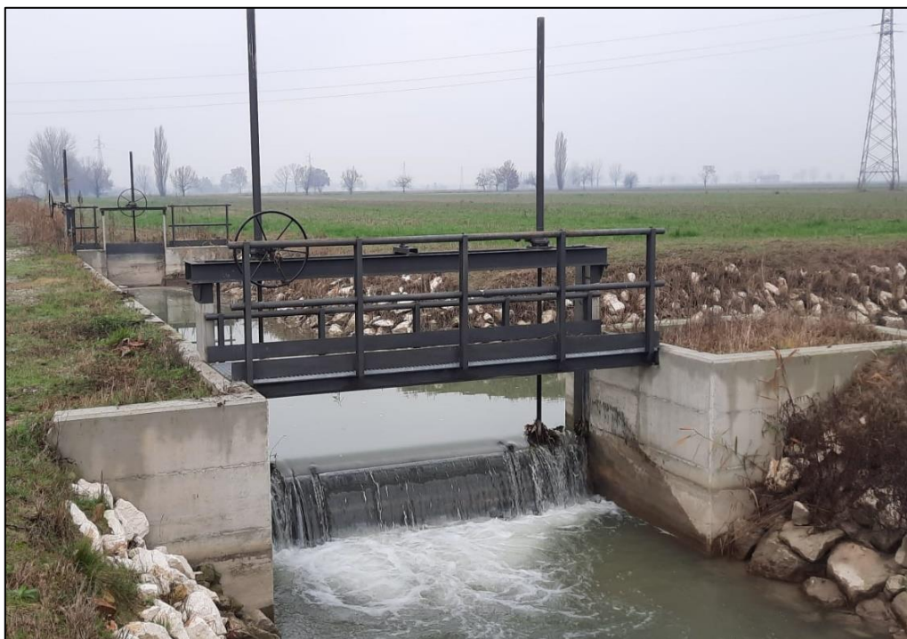
Fig. 2.34 – Lavori di riqualificazione e messa in sicurezza della Seriola Piubega in comune di Piubega
