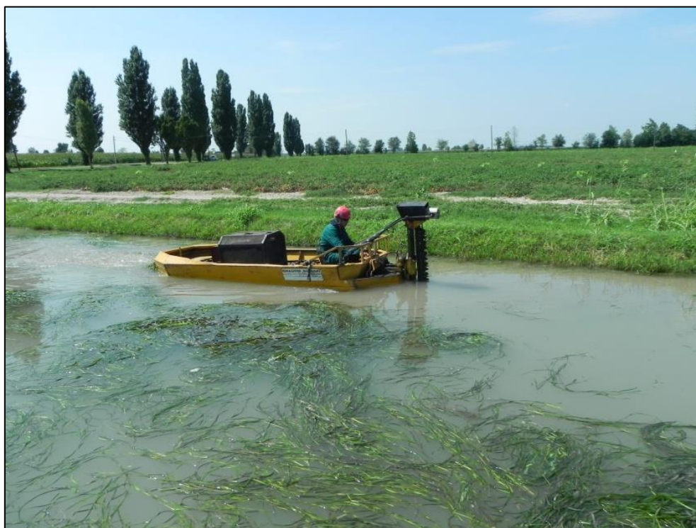
Fig. 2.21 – Sfalcio della vegetazione in alveo
