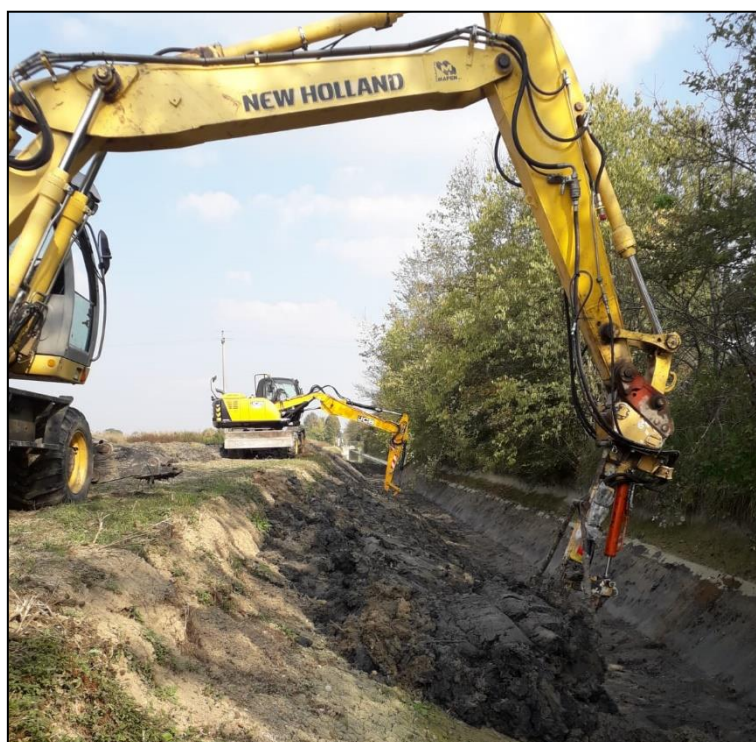
Fig. 2.19 – Espurgo e risagomatura alveo
