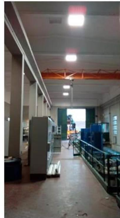
Sostituzione corpi illuminanti esistenti con lampade led
