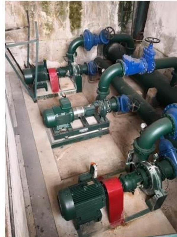
Sostituzione pompa n. 2 da 50 l/s centrale di rilancio Monte Pagano
