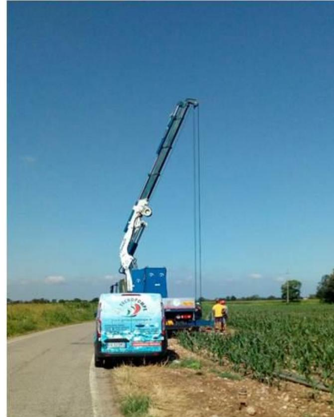
Sostituzione pompa elettrosommersa guasta centrale Montagnoli durante la stagione irrigua
