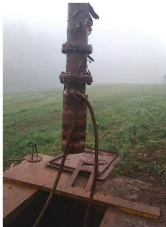
Estrazione e installazione di nuova pompa elettrosommersa guasta
