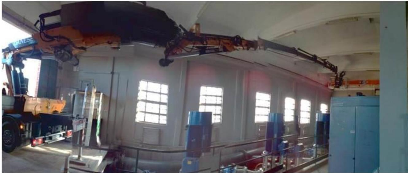
Sostituzione corpi illuminanti esistenti con lampade led centrale
