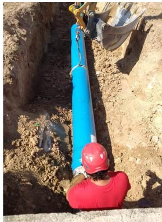
Sostituzione condotta DN 500 linea principale impianto pluvirriguo
