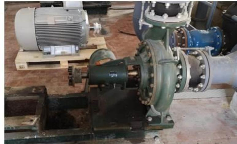
Sostituzione pompa 110 l/s
