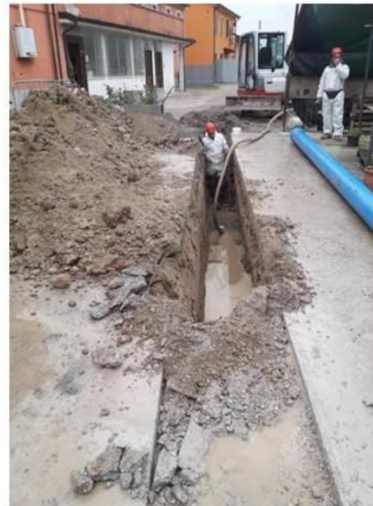
**Sostituzione condotta DN 250 linea principale impianto pluvirriguo
