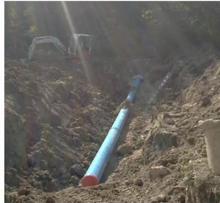
Sostituzione condotta a valle del sottopasso dello Scolo Redone
