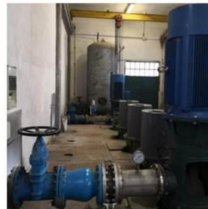
Sostituzione gruppo pompante n. 1 con pompa da 250 l/s
