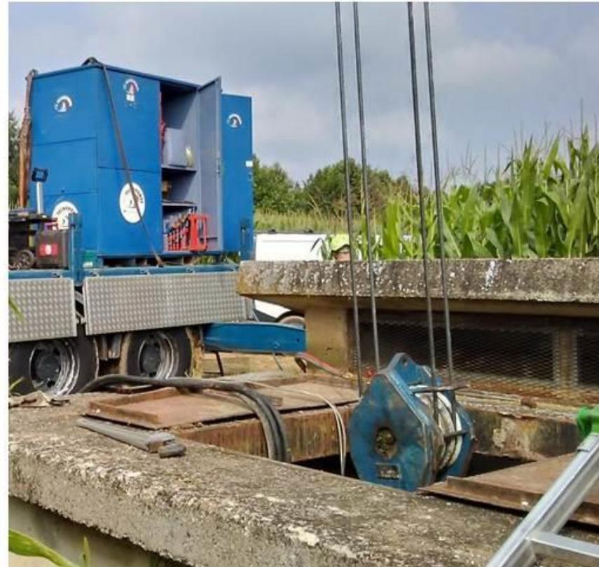
Sostituzione pompa elettrosommersa centrale Sacca
