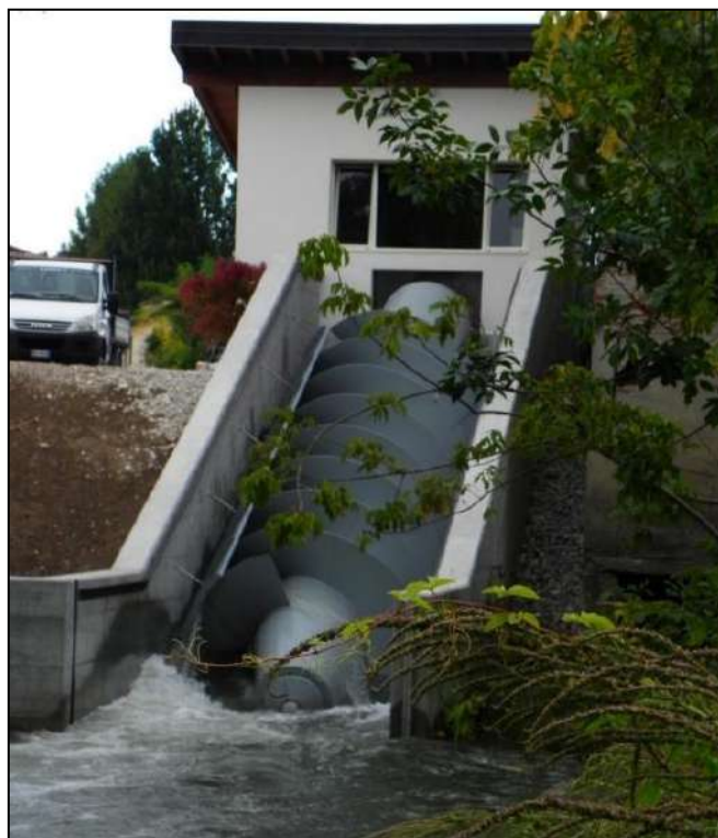
Fig. 2.16 – Centrale idroelettrica Mulino Cartara in Comune di Canneto sull'Oglio
