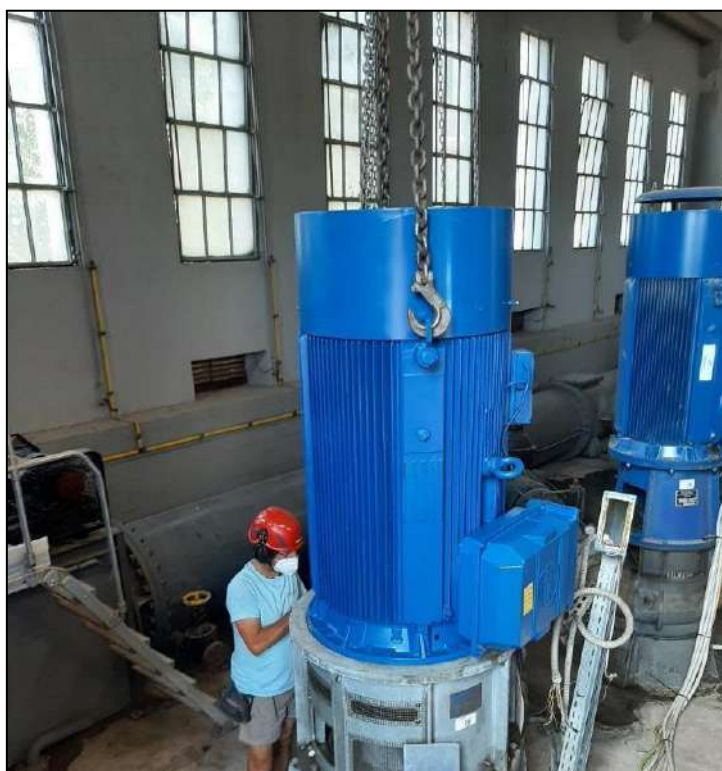
Fig. 2.27 – Riparazione degli impianti elettromeccanici
