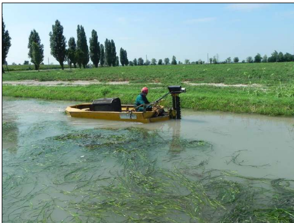
Fig. 2.21 – Sfalcio della vegetazione in alveo
