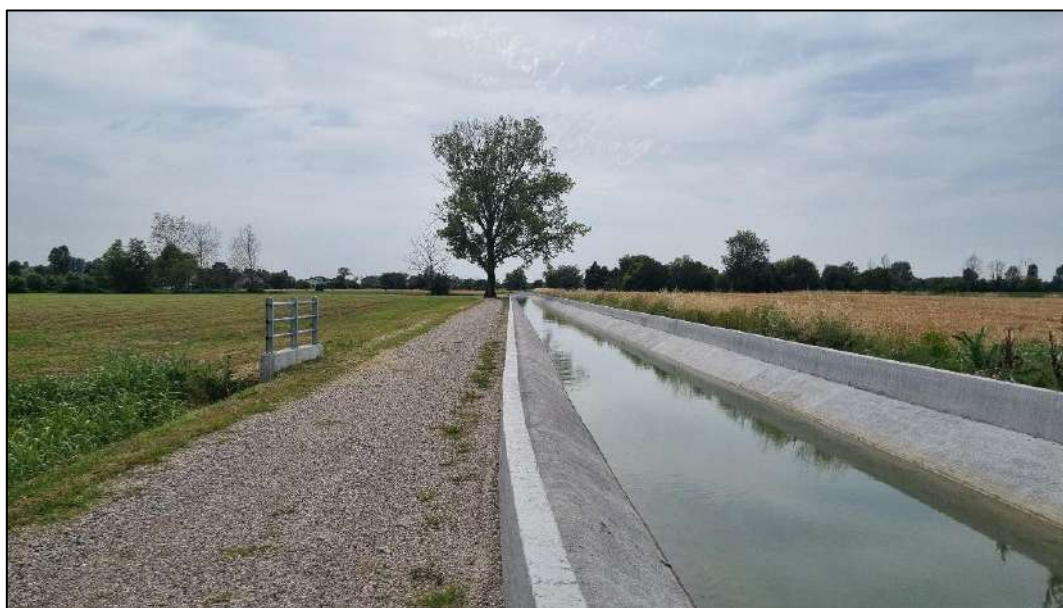
Fig. 2.37 – PSRN Lavori di ripristino e riqualificazione funzionale del “Canale Secondario di Casalmoro” in Comune di Castel Goffredo
