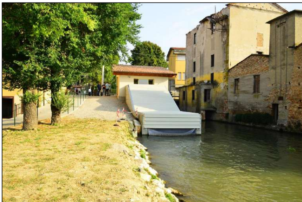
Fig. 2.17 – Centrale idroelettrica Mulino San Giuseppe – Einstein in Comune di Canneto sull'Oglio
