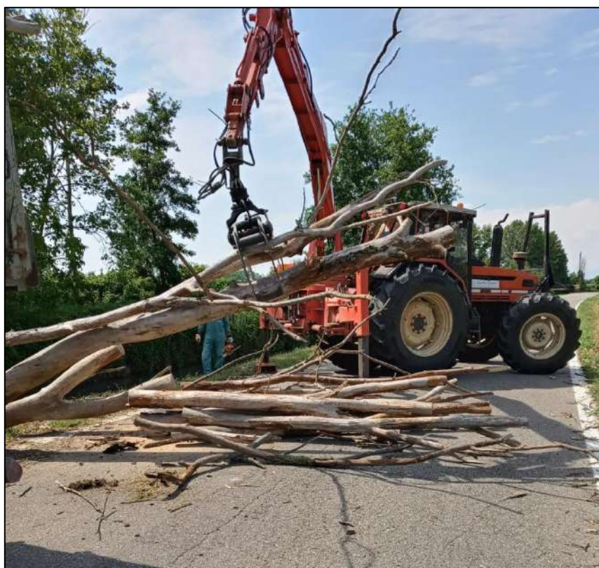
Fig. 2.22 – Rimozione alberature cadute in alveo
