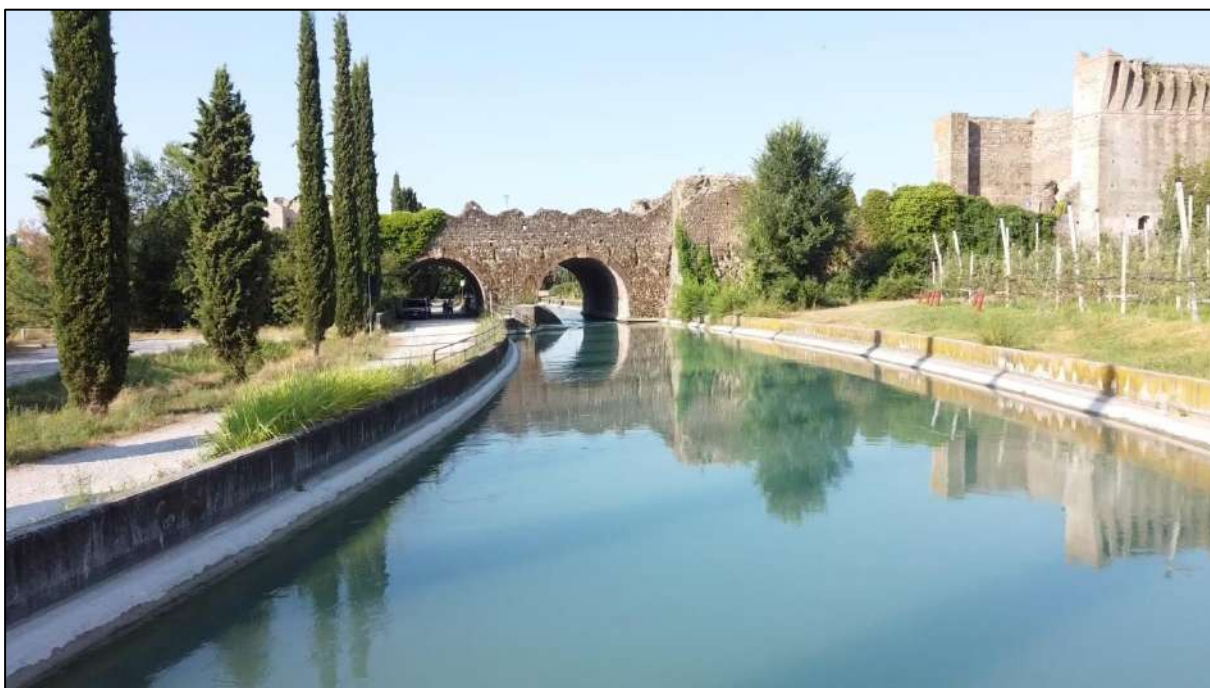
Fig. 2.9 – Canale Virgilio: attraversamento del ponte visconteo a Borghetto di Valeggio sul Mincio
