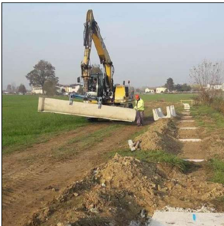
Fig. 2.26 – Sostituzione di tratti di reti irrigue ammalorate
