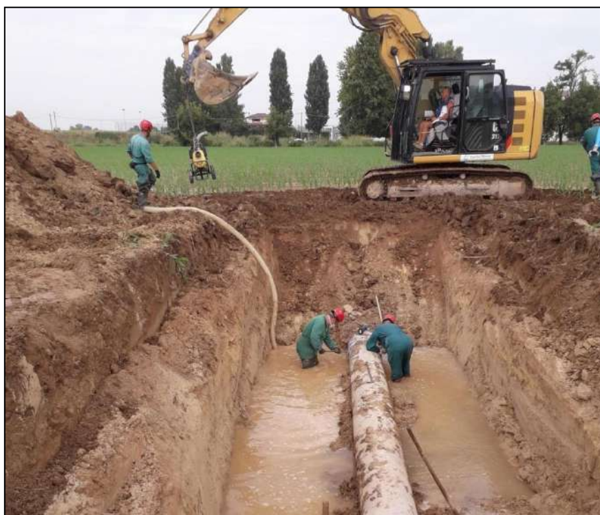
Fig. 2.25 – Riparazioni condotte irrigue
