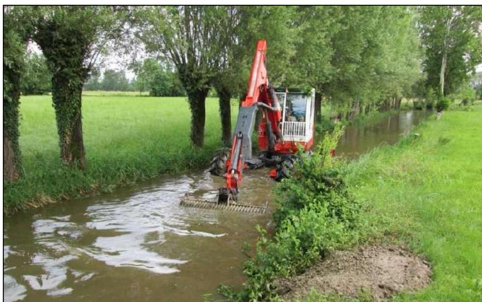
Fig. 2.20 – Espurgo alveo
