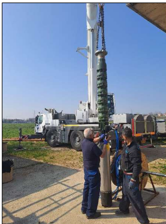
Fig. 2.40 – Intervento di somma urgenza per la riparazione di n.3 pozzi nel bacino irriguo Pozzolengo
