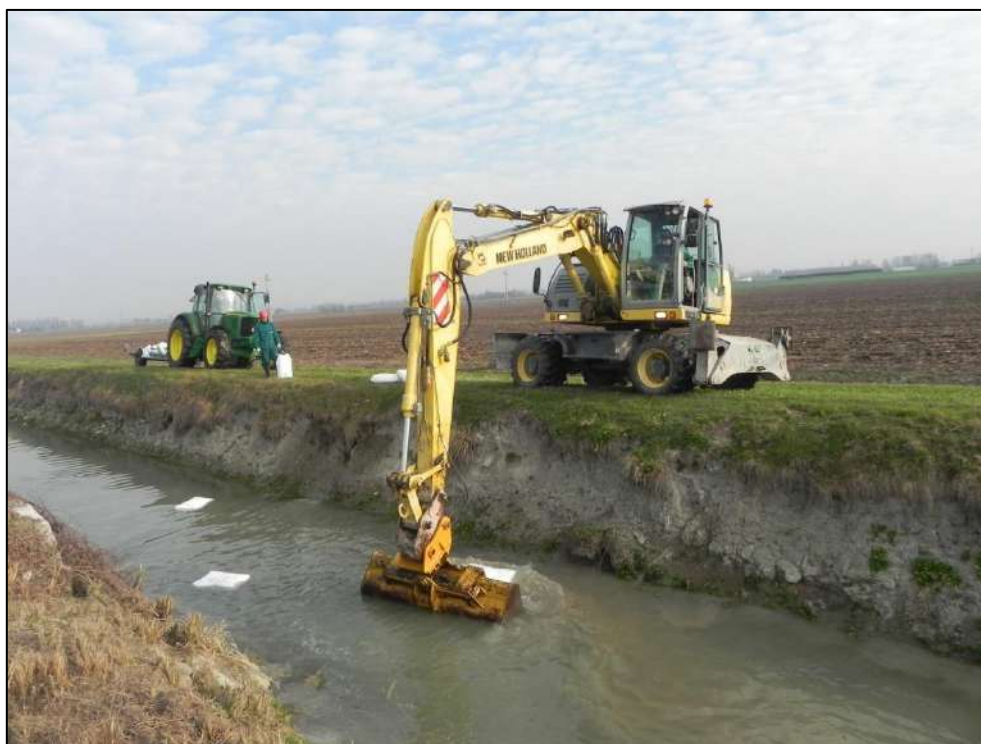
Fig. 2.23 – Rimozione dei rifiuti abbandonati in alveo
