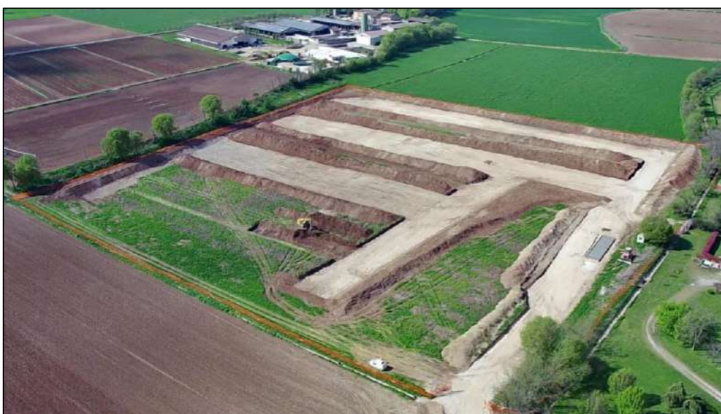
Fig. 2.35 – Realizzazione vasca di laminazione del Fosso Re in Comune di Cavriana
