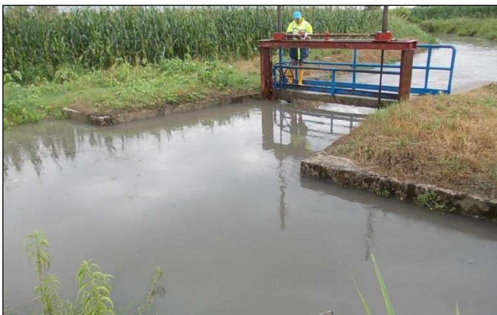
Fig. 2.28 – Manovre di regolazione dei manufatti sui canali
