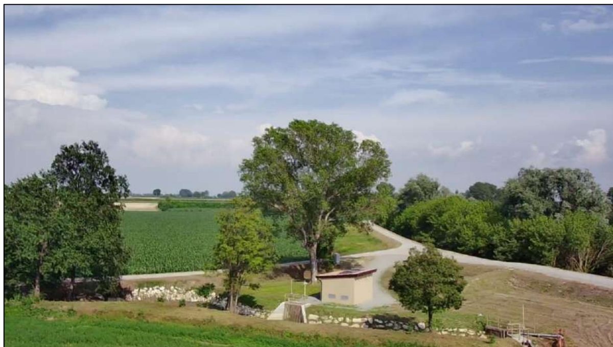
Fig. 2.11 – Impianto idrovoro Gambolo in Comune di Canneto sull'Oglio
